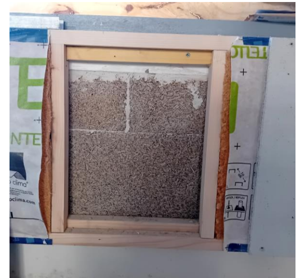
Fenêtre de vérité en travaux
