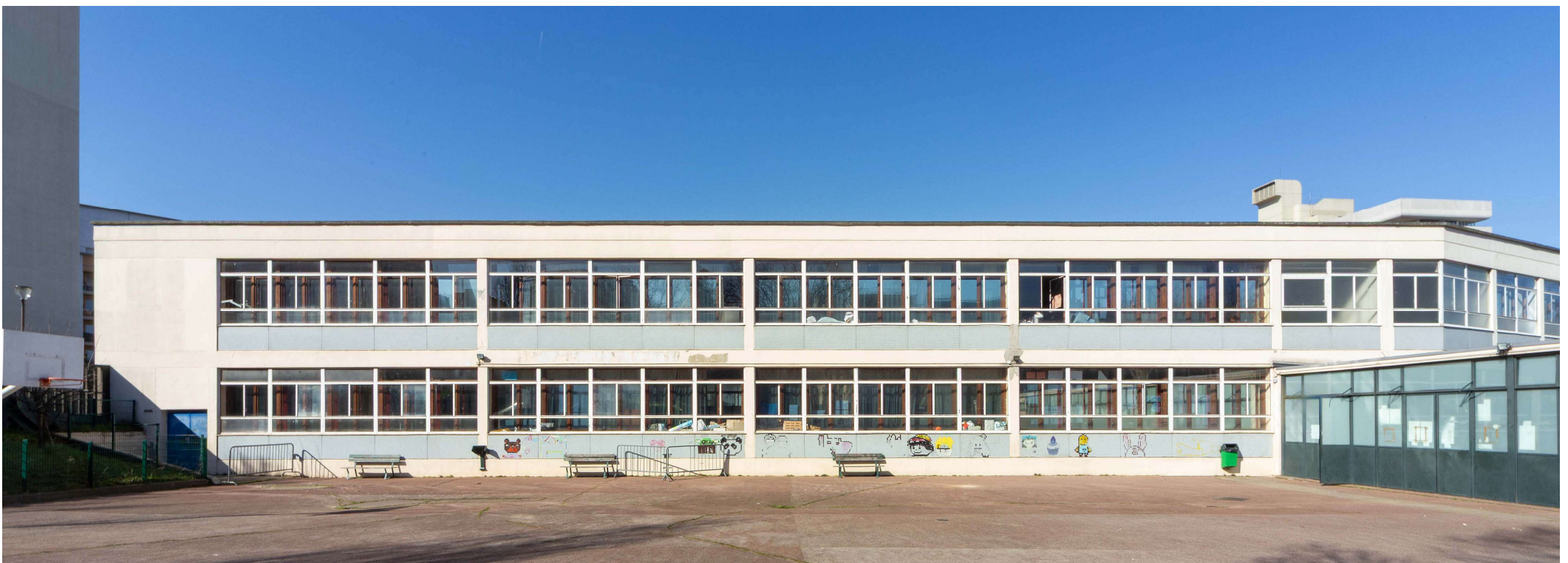
Façade SUD avant travaux
