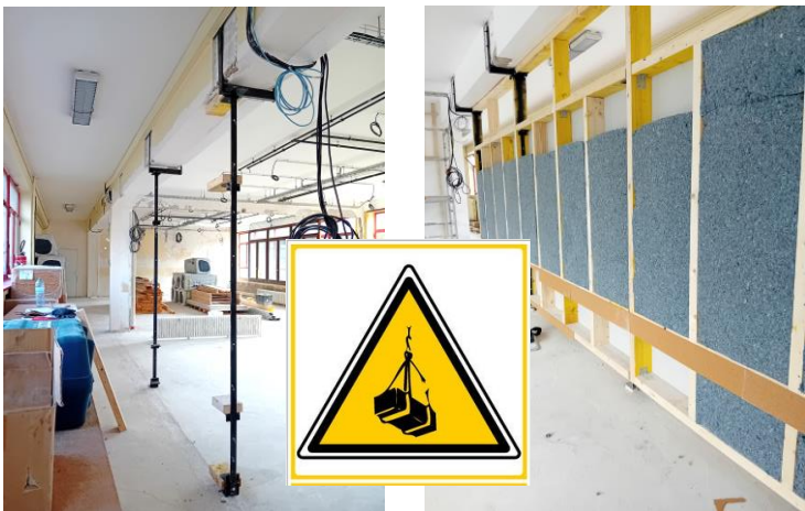
Cloison ossature bois au RDC
