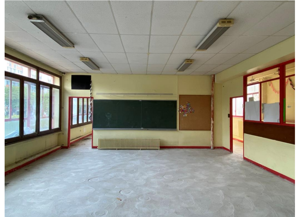
Façade sud et salle de classe – état après déplombage du sol
