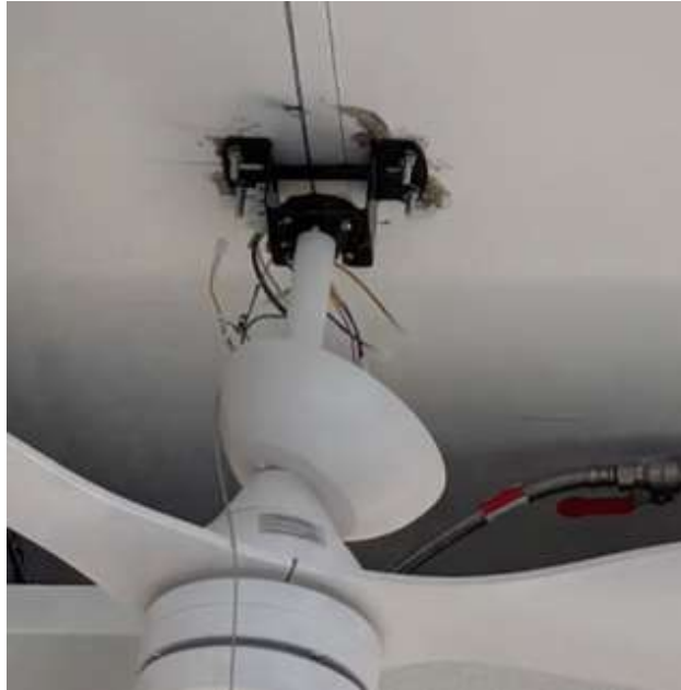
Figure 1 : fixation platine avec 4 ancrages au plafond RDC
