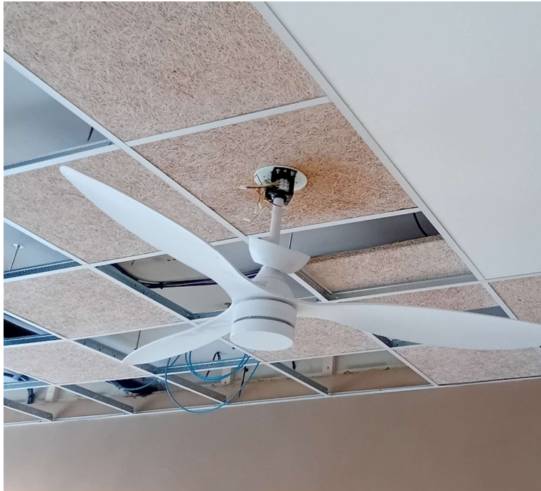
Figure 3 : platine de fixation du brasseur fixée directement sur la sous face de la tige télescopique
