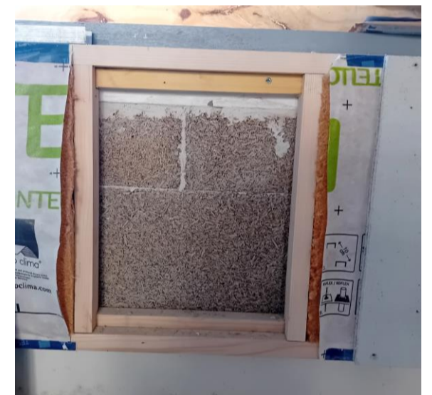
Fenêtre de vérité en travaux
