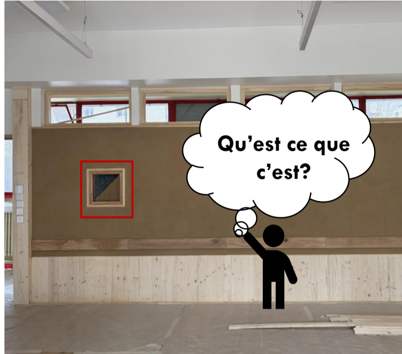
Fenêtre de vérité cloison du couloir
