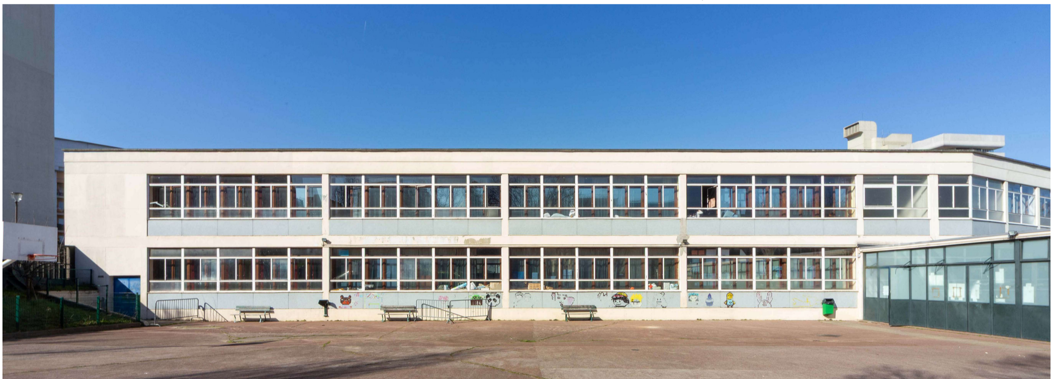
Façade SUD avant travaux
