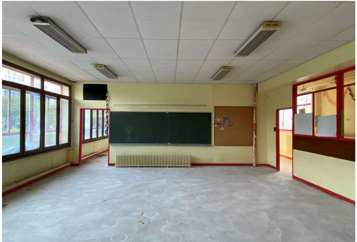
Salle de classe avant travaux (sol déjà déplombé)
