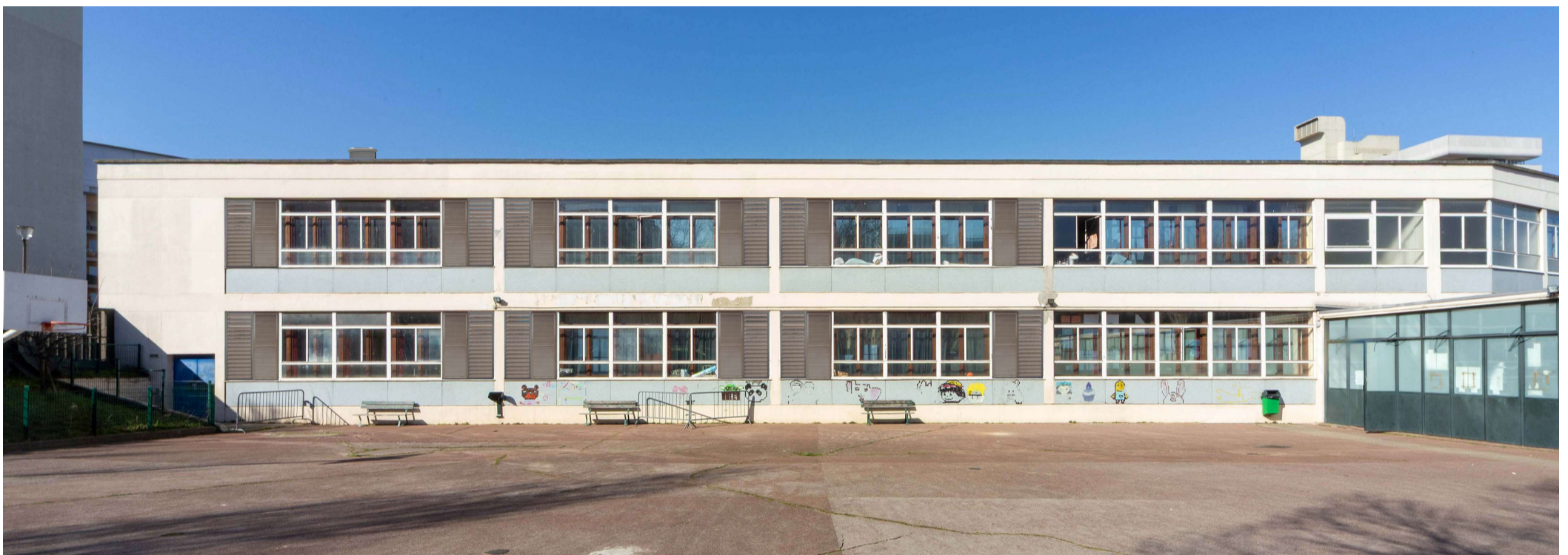
Façade SUD APRES travaux
