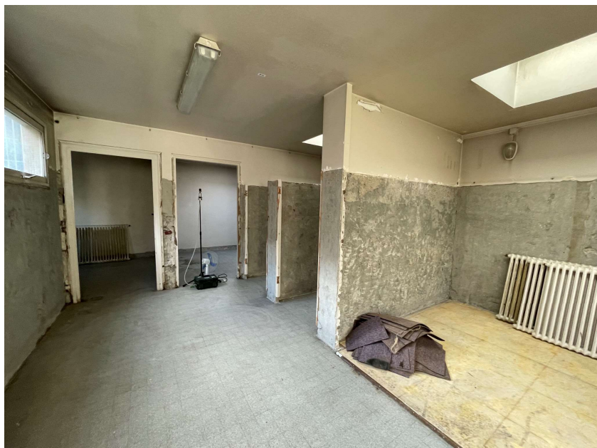
Visuel avant travaux
