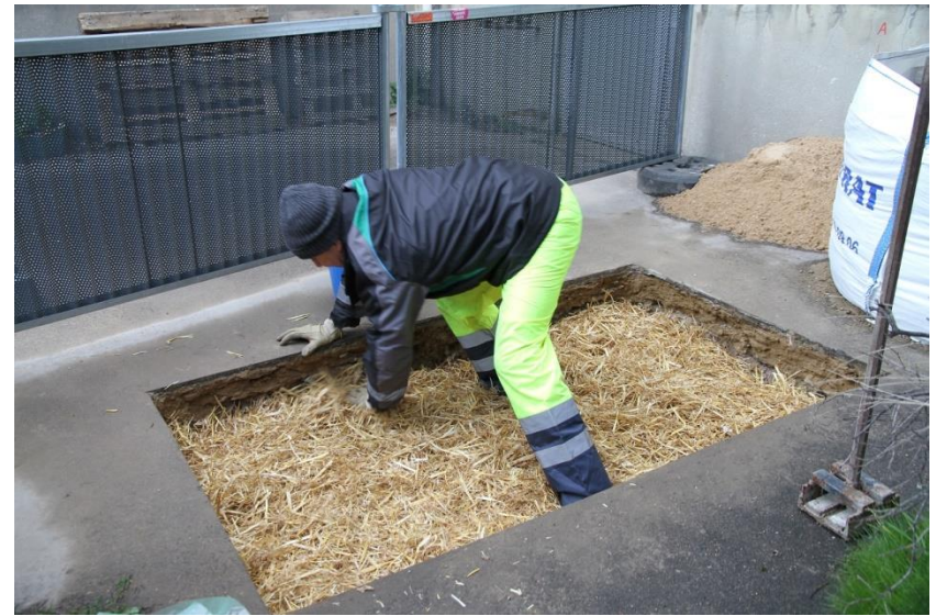
2# Mettre la paille [10cm non compactée]
