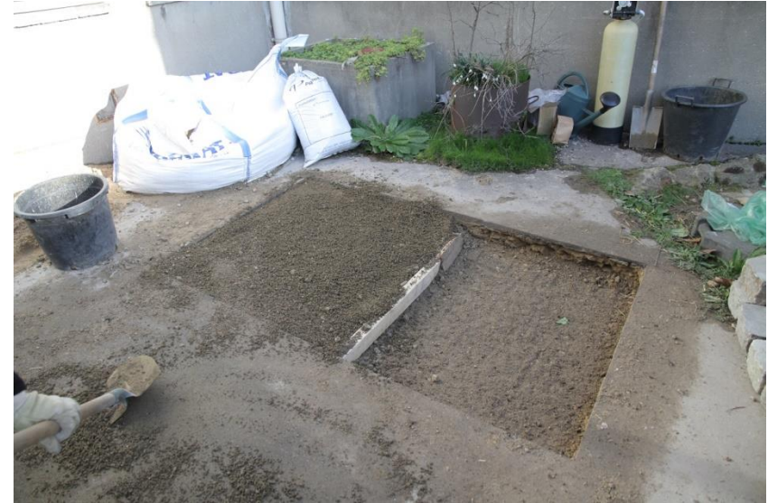
5# Mélanger et disposer 2cm de 0/10 + FALITAL® + graines TALPAFLORE®
