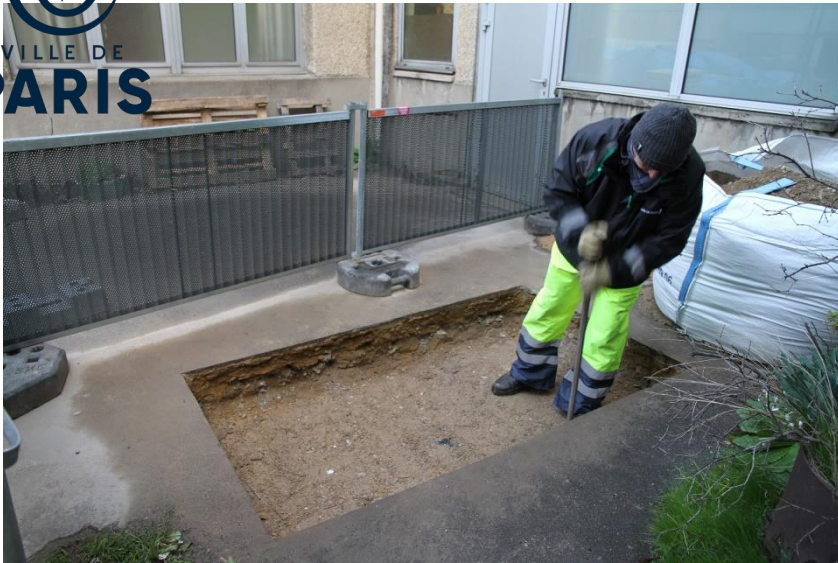
1# Compacter le fond de fouille
