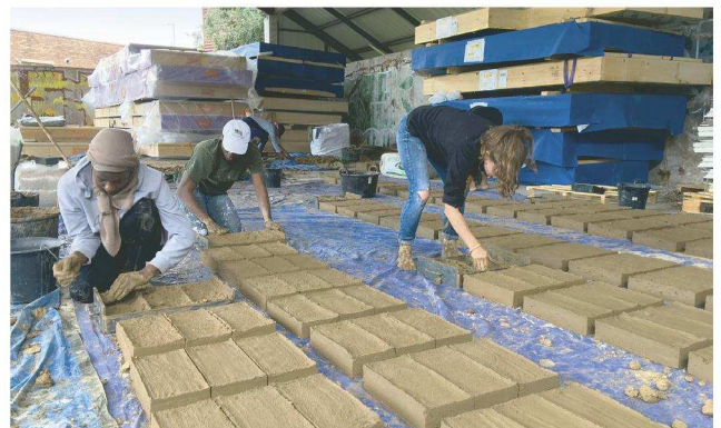
Lors de l'extension de l'école Ivry-Levassor, 17 femmes mobilisées par l'Armée du salut ont monté les premières briques en terre crue.
