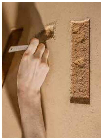
Chantier enduit de finition à la main sur support placo - Entreprises Terramano & Calyclay
