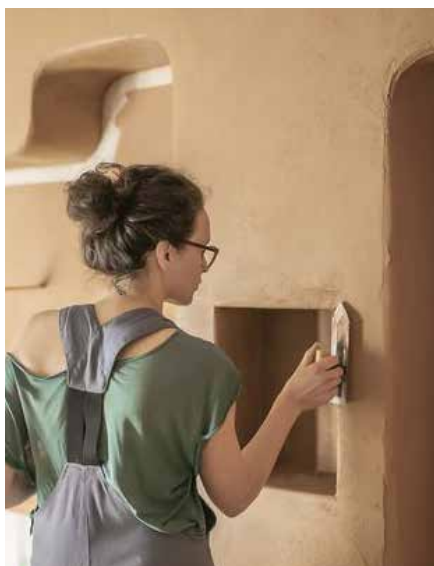
Chantier enduit de finition à la main sur support placo - Entreprises Terramano & Calyclay
