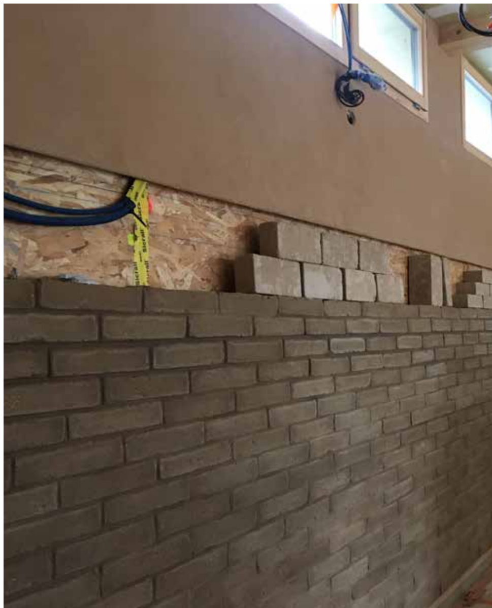
Construction terre crue & réemploi par Les Bâtisseuses Frédérique Jonnard & Eugénie N'Diaye
