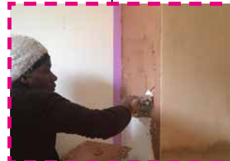
Enduits de finition
