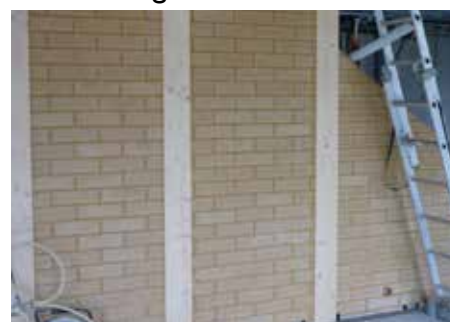
BTC en remplissage d'ossature
