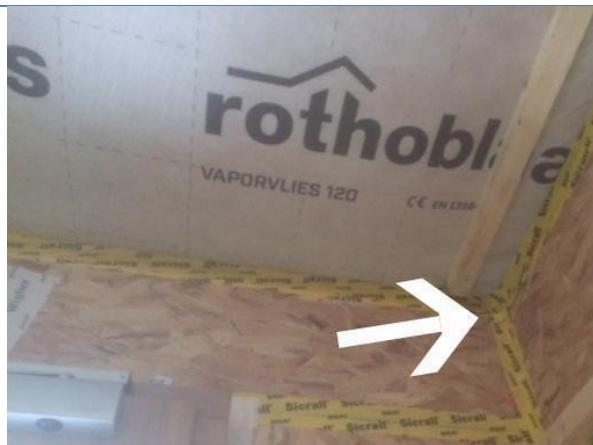
**Type :** B4-Liaison mur / plancher haut ou toiture inclinée (cueillie de plafond)/pied de cloison, pied de mur
