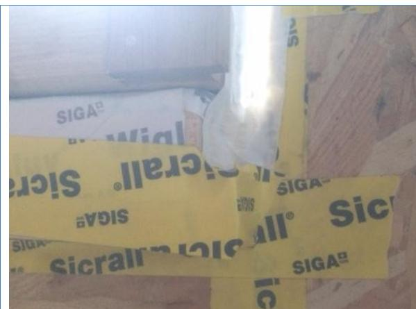
**Type :** B3-Liaison pied de mur / plancher (plinthes, ...)
