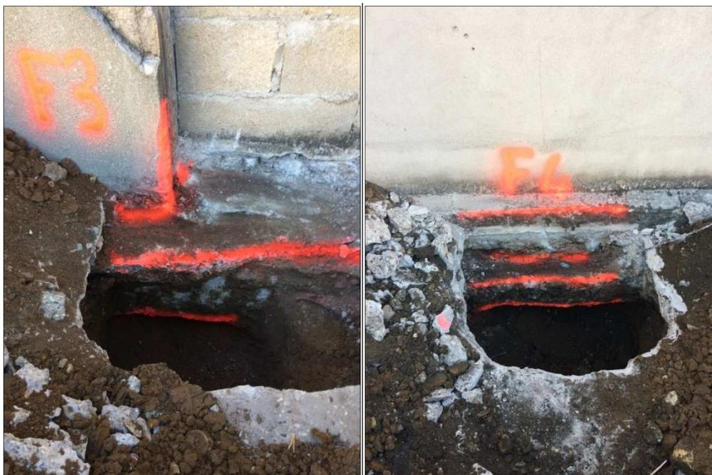
Des semelles filantes en béton sous les murs reconnus ont été découvertes dans ces fouilles. Elles s'appuient sur des sables légèrement argileux marron qui appartiennent à l'horizon H0 à 0,6 et 0,43 m de profondeur. On soulignera le fait que la semelle en F4 ne respecte pas la garde au gel.
