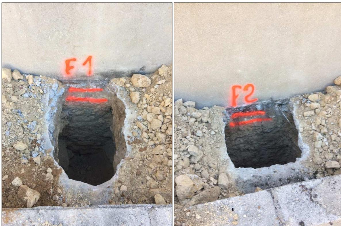
La base des fondations n'a pas été reconnue dans ces fouilles menées à 1,5 m de profondeur. Un percement a permis d'estimer la base du mur à une profondeur approximative de 2,2 m. Cette profondeur peut s'expliquer par la présence d'un niveau enterré dont la présence nous a été communiqué après la réalisation des fouilles. Le sol d'assise n'est pas connu ici.
